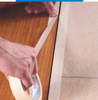
Application d'un ruban adhésif pour la protection du support lors du remplissage du joint
